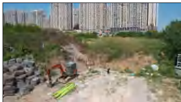
弃渣场北面渣体边坡现状图，坡面已有植物护坡，边坡稳定，无滑坡现象
