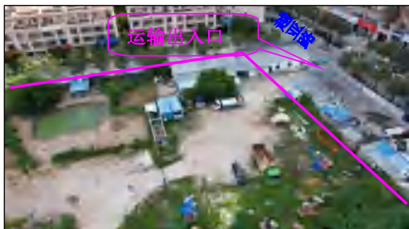
弃渣场北面弃渣运输出入口现状
