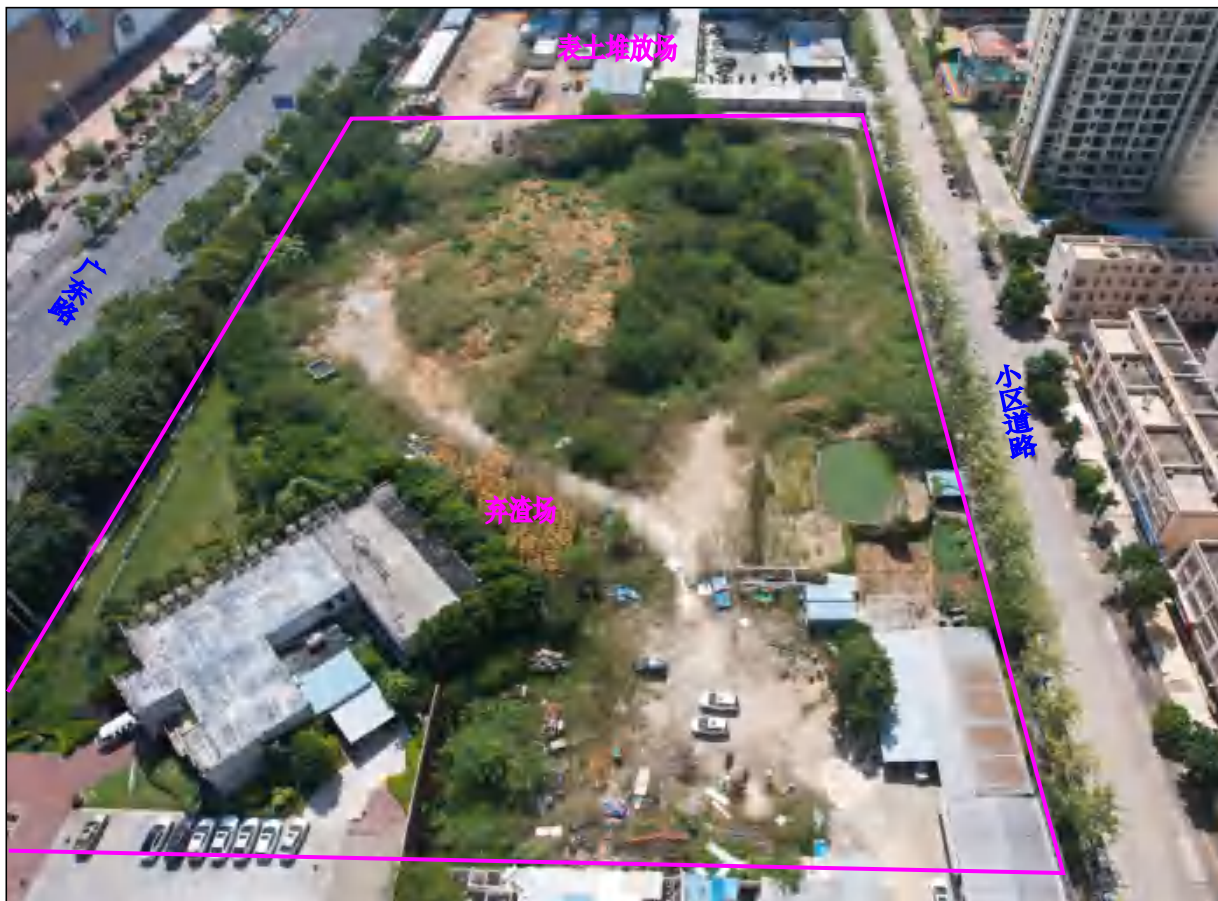
弃渣场用地现状图，弃渣已采取绿化措施，大部分区域现状植被生长状况较好，但小部分区域因车辆碾压等，无植被生长，弃渣场现状存在一定水土流失
