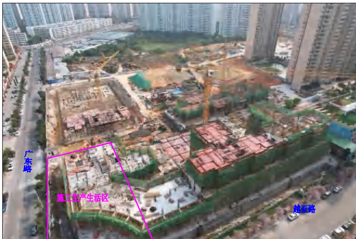
施工生产生活区现状用于天赐御园三期项目建设，用于项目建设后水土流失防治责任转移至对应建设的项目
