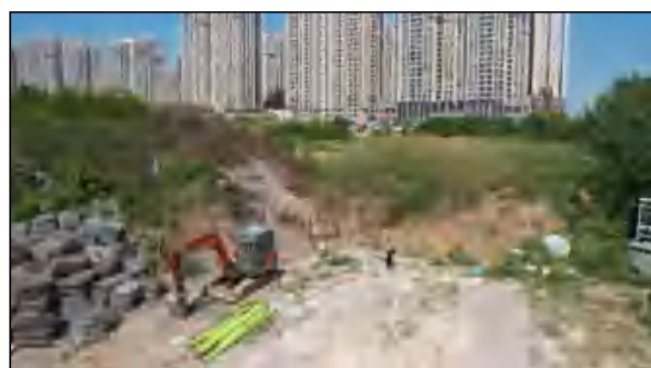
弃渣场北面渣体边坡现状图，坡面已有植物护坡，边坡稳定，无滑坡现象
