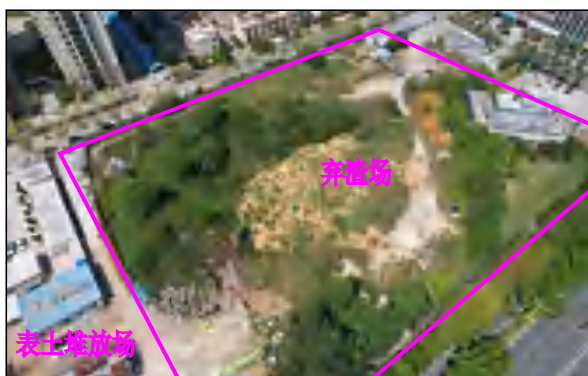
弃渣场南面用地现状
