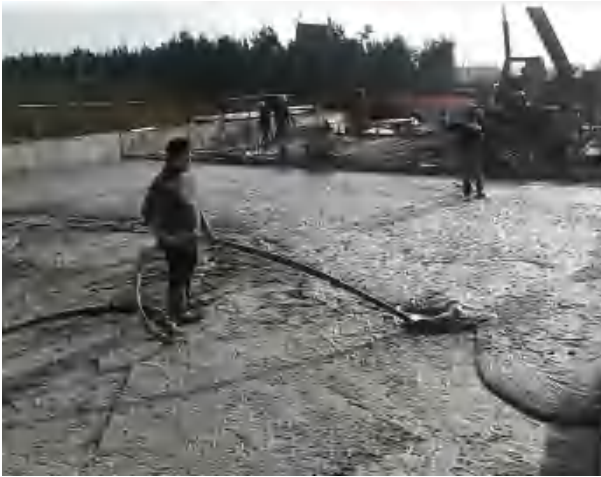
桥梁泡沫混凝土施工
