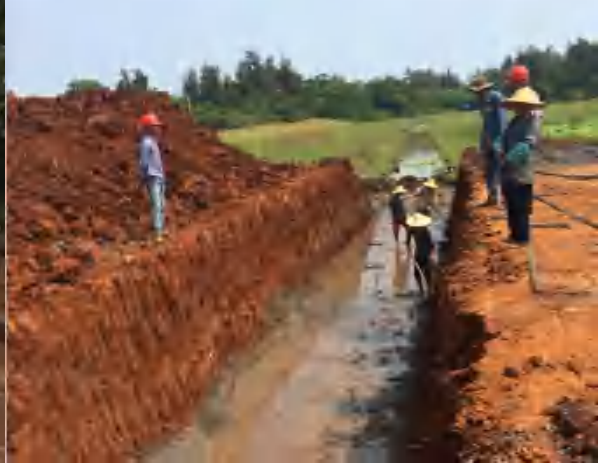
涵洞施工开挖
