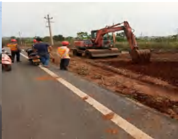
人行道路床整理
