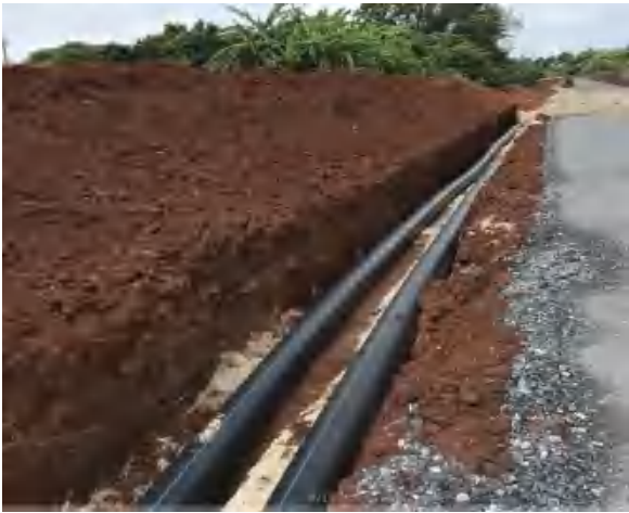
路污水压力管道施工
