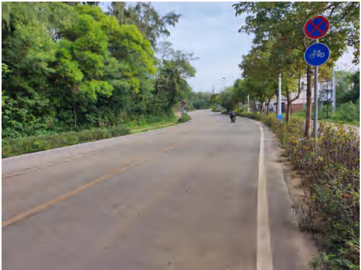
道路沿线路面及植被恢复现状情况
