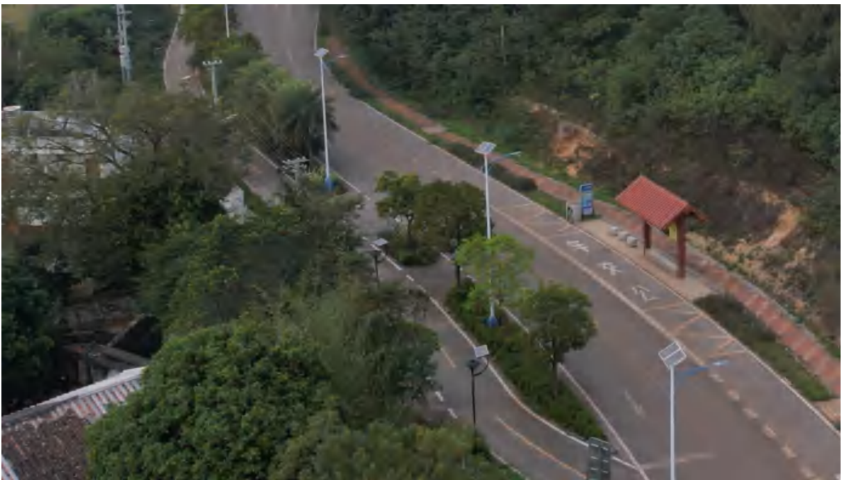
道路沿线路面及植被恢复现状情况
