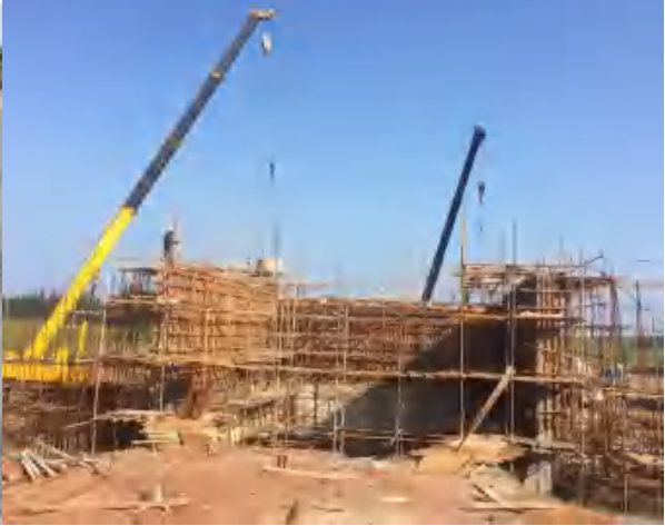
桥台混凝土浇筑
