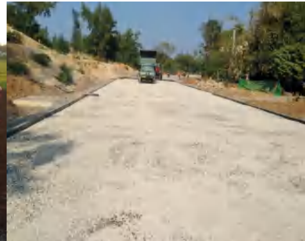
沥青下封层施工
